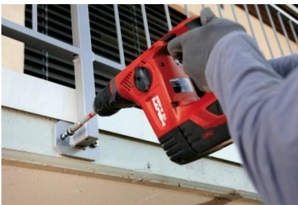
Ankerplaatsing na plaatsen van de voetplaat
