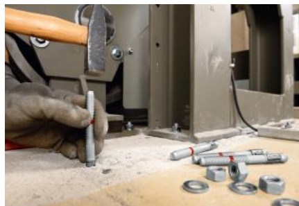
Ankerplaatsing voor plaatsen van de voetplaat
