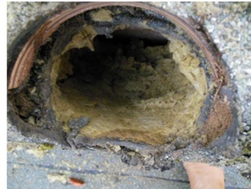
Foto 3: Boring 1 dakrand - houten dakplaat en isolatie zijn droog
