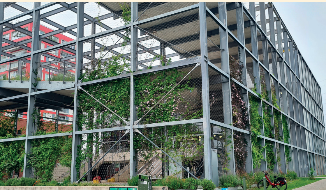
Oude Dokken: Melopee gebouw met de FAAR woontoren op de achtergrond.
